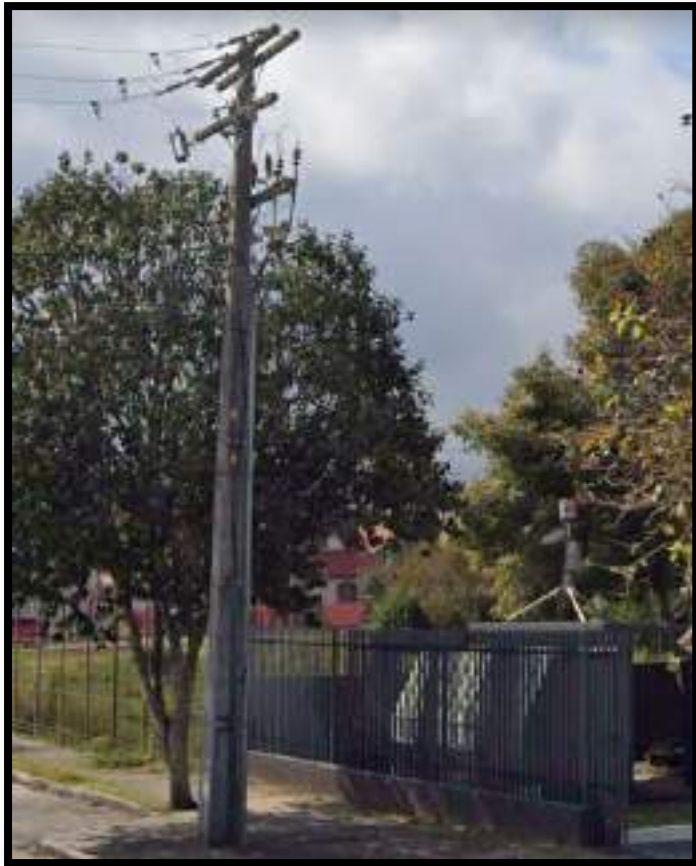
Foto 01:Entrada em Alta Tensão com subestação blindada
