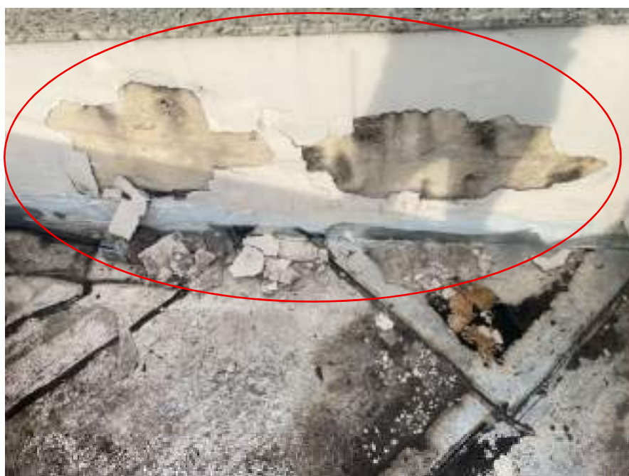
Fotografia 91 - fissuração e deslocamento do revestimento generalizada por infiltração
