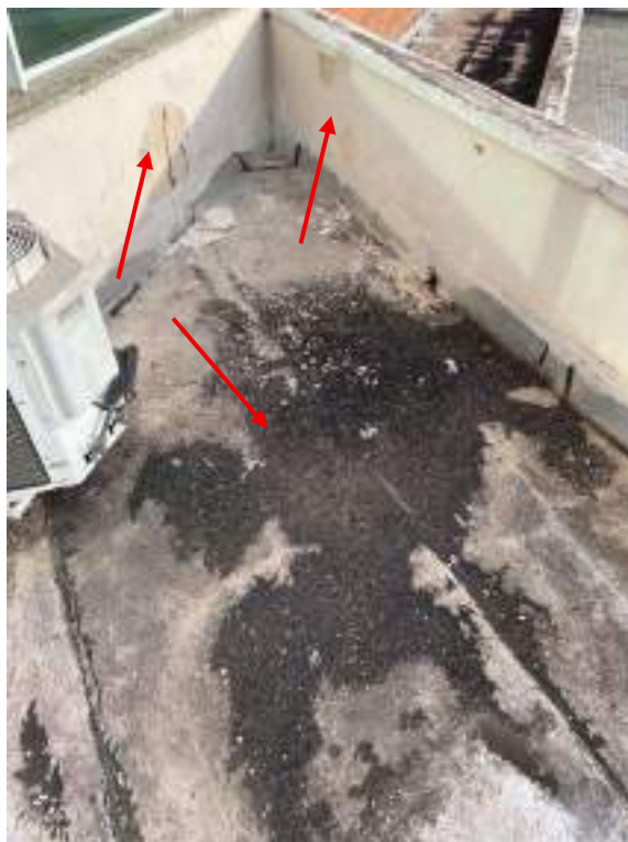
Fotografia 86 - Sistema de impermeabilização ineficiente / infiltrações na platibanda
