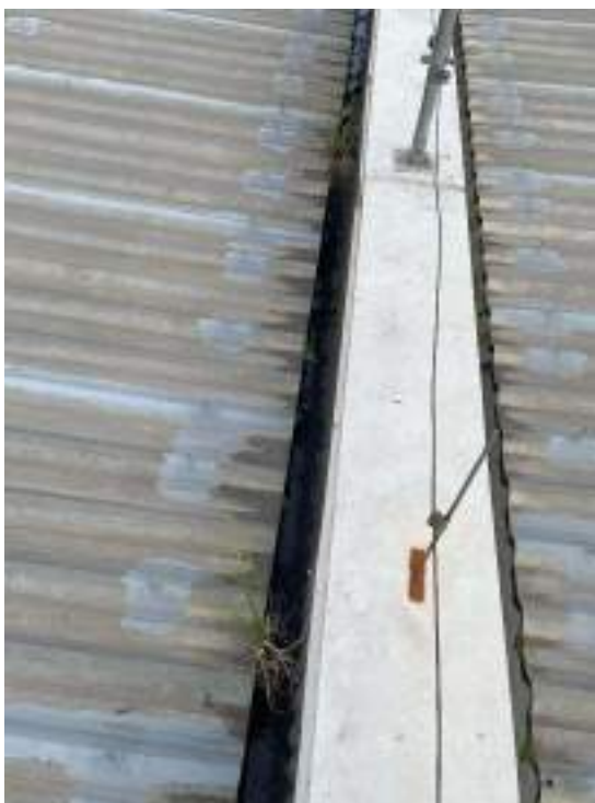
Fotografia 103 - Presença de vegetação nas calhas
