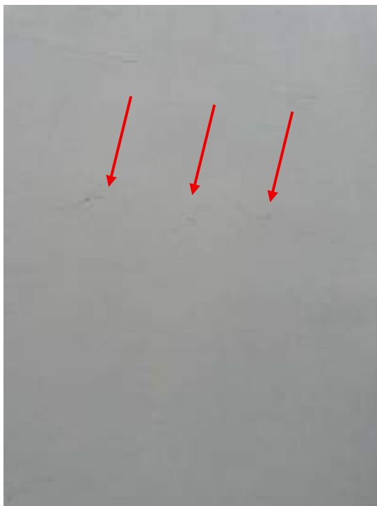
Fotografia 67 - Fissura por provável retração de argamassa
