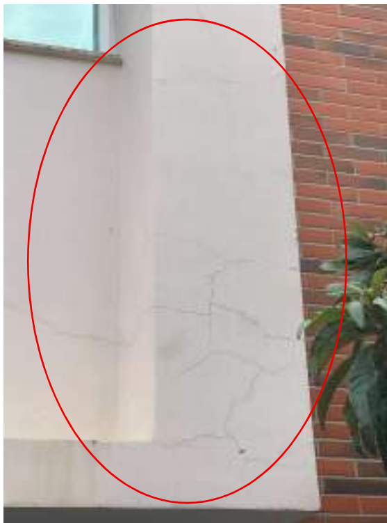
Fotografia 39 - Fissura por provável retração de argamassa
