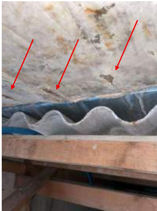
Fotografia 112 - Laje da caixa d'água apresenta aço exposto e corroído Classificação: vício, congênito, endógeno
