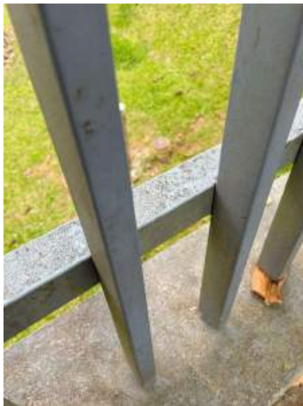
Fotografia 5 - Corrosão da pintura
