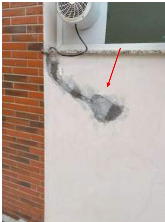
Fotografia 59 - Reboco mal acabado e com fissuras aparentes
