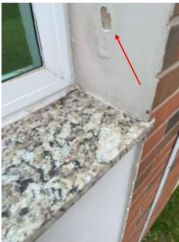
Fotografia 19 – Infiltração / Pulverulência de revestimento tipo emboço de fachada
