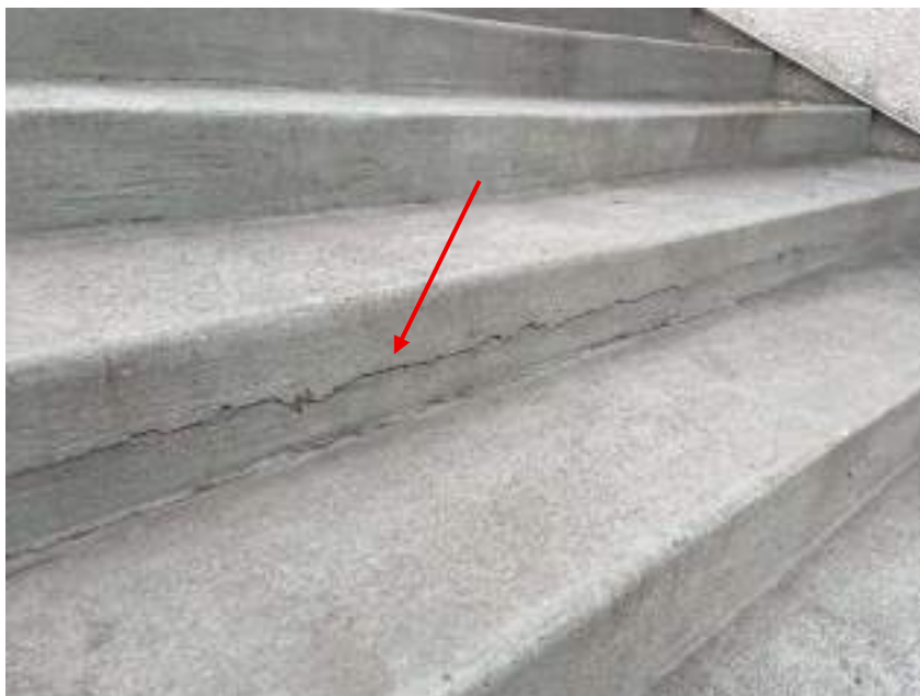
Fotografia 121 - Fissuração contrapiso escada
