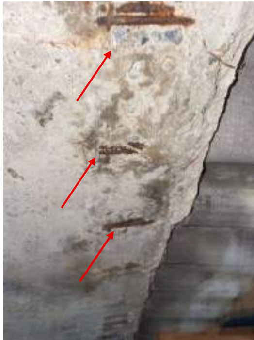
Fotografia 111 - Laje da caixa d'água apresenta aço exposto e corroído Classificação: vício, congênito, endógeno
