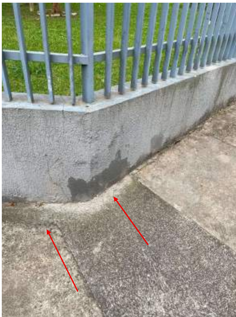
Fotografia 4 - fissura por provável retração de argamassa / Infiltração
