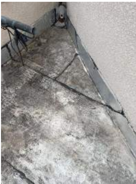
Fotografia 78 - Impermeabilização ineficiente; laje do auditório do plenário
