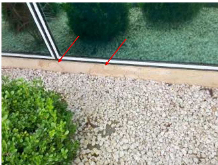
Fotografia 73 - Pulverulência de revestimento tipo emboço de fachada
