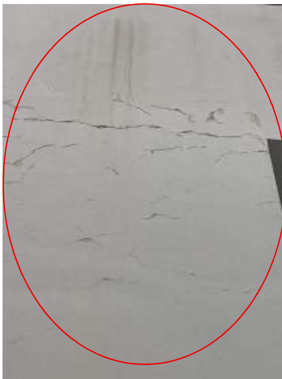
Fotografia 38 - Fissura por provável retração de argamassa
