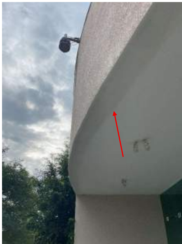
Fotografia 48 - Sinais de infiltração forro de gesso
