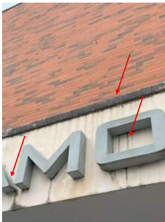
Fotografia 54 - Corrosão do rufo e manchas na pintura e letreiros da fachada
