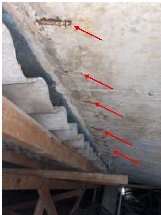
Fotografia 113 - Laje da caixa d'água apresenta aço exposto e corroído
