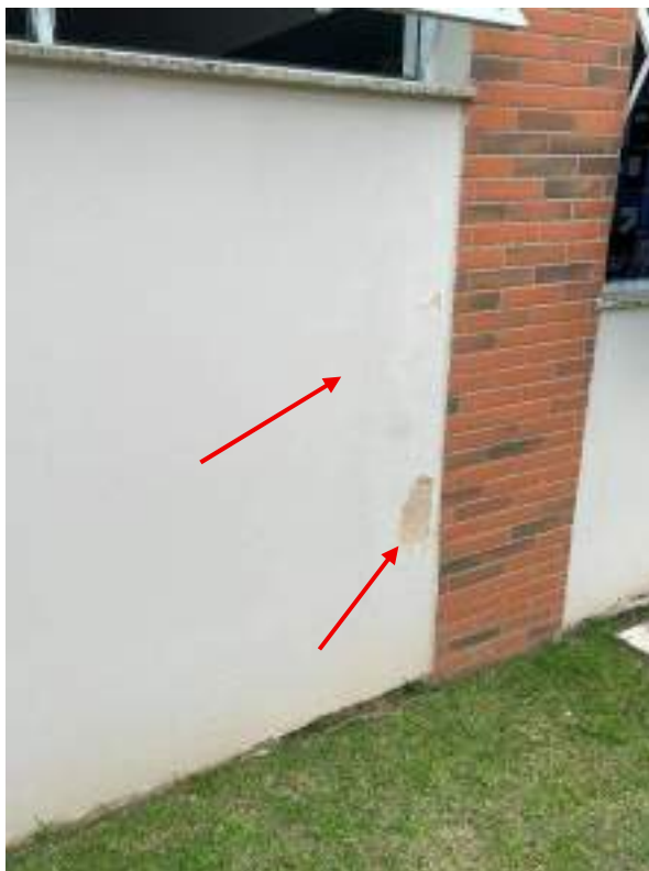
Fotografia 14 - Fissura por provável retração de argamassa / Infiltração Classificação: Vício, congênito / adquirido, endógeno.
