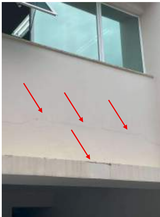
Fotografia 37 - Fissura por provável retração de argamassa
