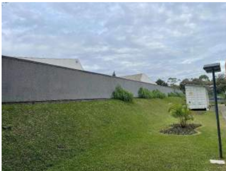
Fotografia 8 – Manchas e fungos na pintura do muro.
