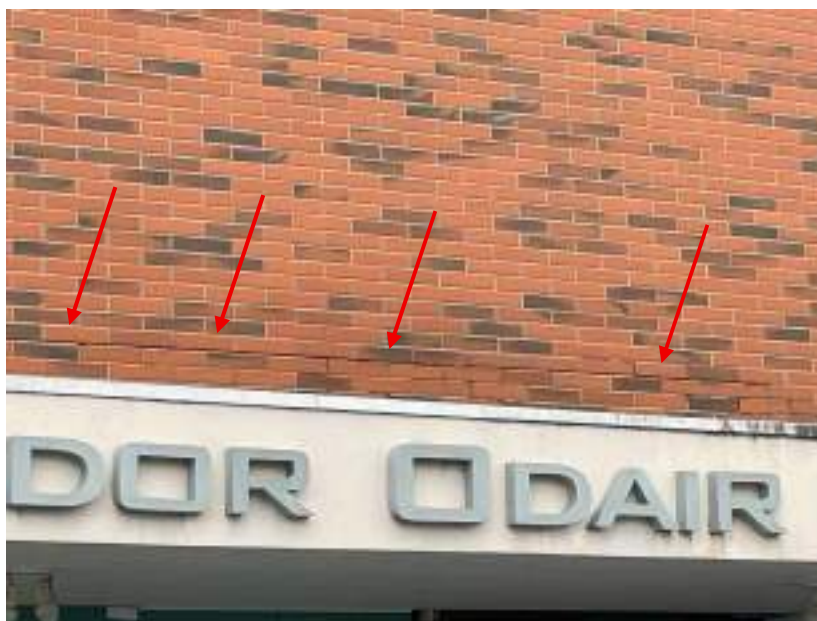
Fotografia 53 - Indícios de falha no rejuntamento e possível infiltração.
