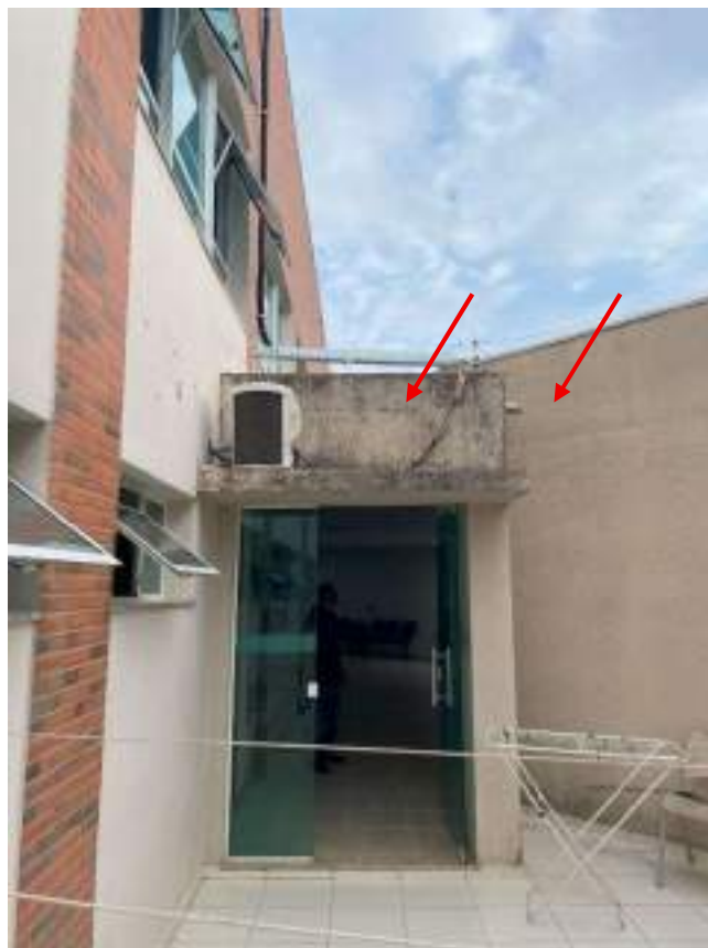
Fotografia 64 - manchas negras / infiltração
