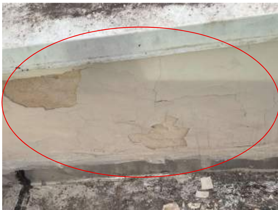
Fotografia 89 - fissuração e deslocamento do revestimento generalizada por infiltração
