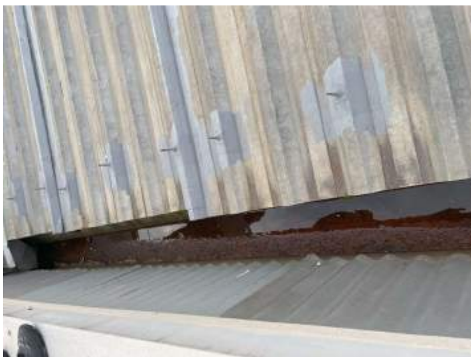
Fotografia 100 - Calhas com caimento irregular e presença de ferrugem
