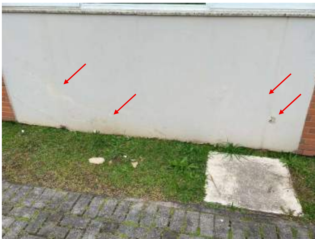
Fotografia 17 - Fissura por provável retração de argamassa / Infiltração
