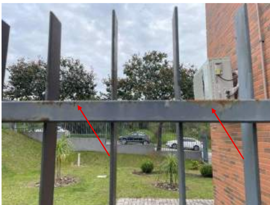
Fotografia 6 - Corrosão da pintura
