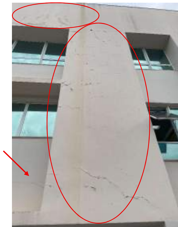
Fotografia 32 - Fissura por provável retração de argamassa
