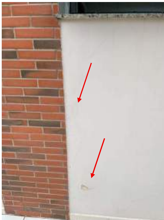
Fotografia 57 - Infiltração / Pulverulência de revestimento tipo emboço de fachada
