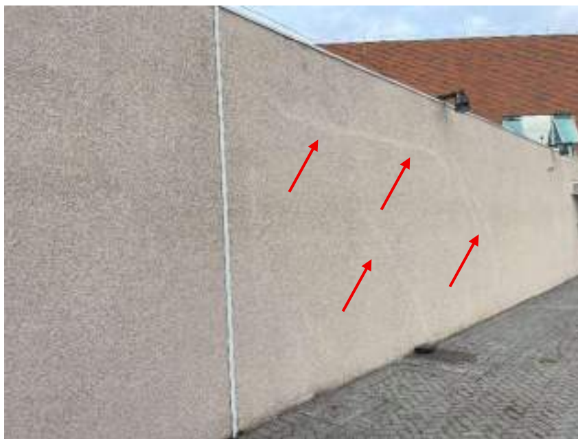
Fotografia 49 - Fissura por provável retração de argamassa
