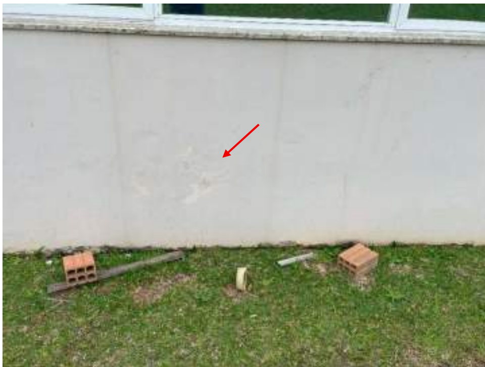
Fotografia 16 - Infiltração
