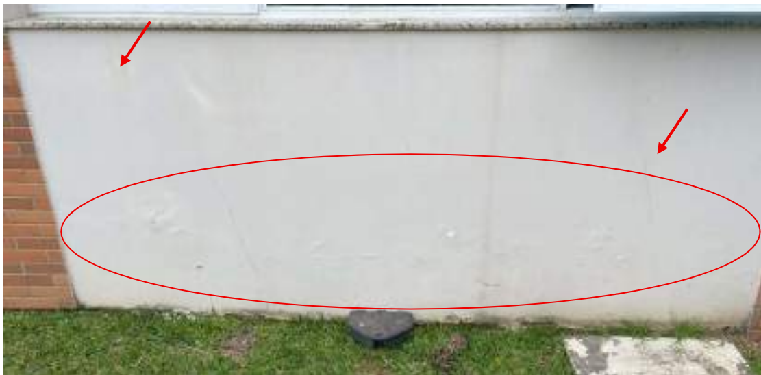
Fotografia 22 - Fissura por provável retração de argamassa / Infiltração
