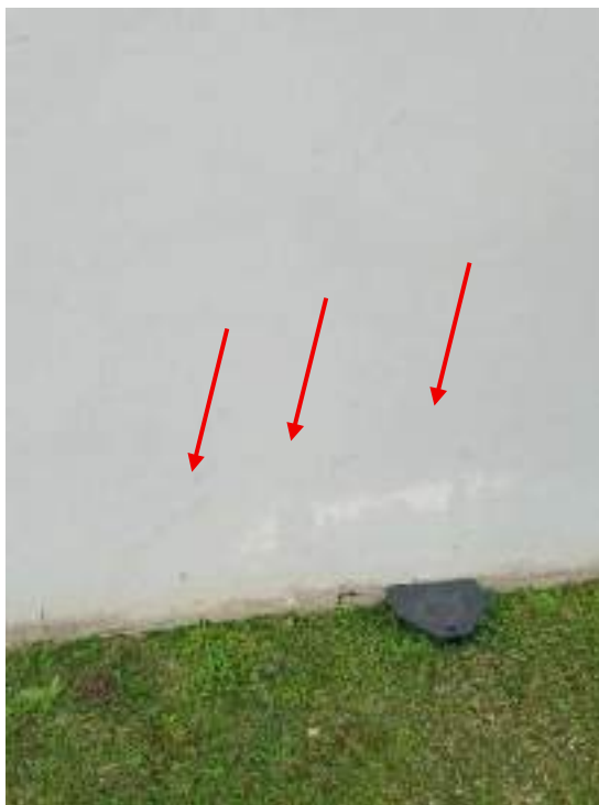
Fotografia 69 - Fissura por provável retração de argamassa
