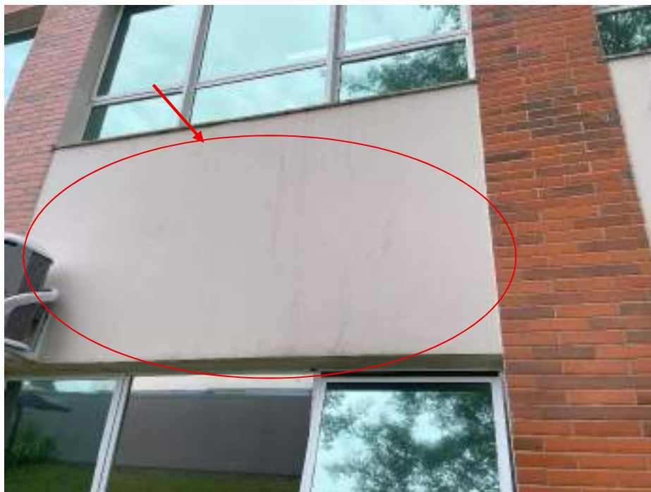
Fotografia 25 - Fissura por provável retração de argamassa / Infiltração
