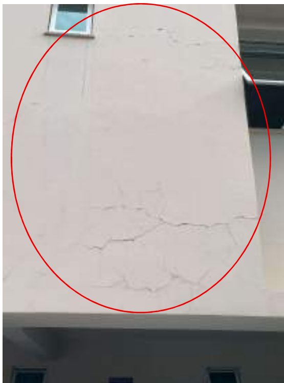
Fotografia 36 - Fissura por provável retração de argamassa
