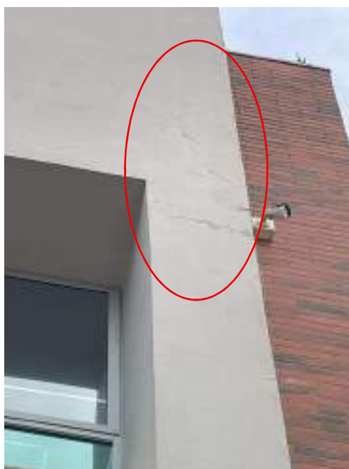
Fotografia 40 - Fissura por provável retração de argamassa
