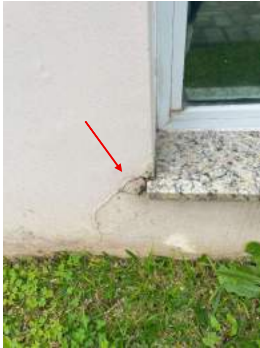
Fotografia 75 - Fissura por provável retração de argamassa
