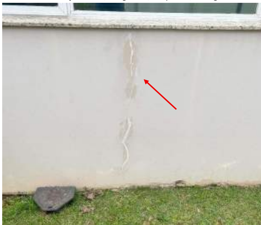
Fotografia 11 - Fissura por provável retração de argamassa / Infiltração
