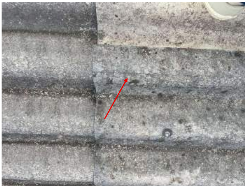
Fotografia 93 - Fissura em telha fibrocimento
