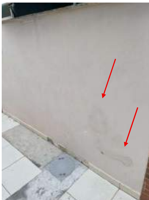
Fotografia 58 - Infiltração parede externa
