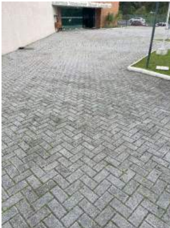
Fotografia 122 - manchas escuras e presença de fundos no piso intertravado
