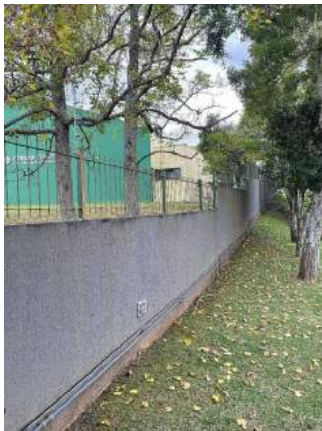
Fotografia 7 - Manchas e fungos na pintura do muro.
