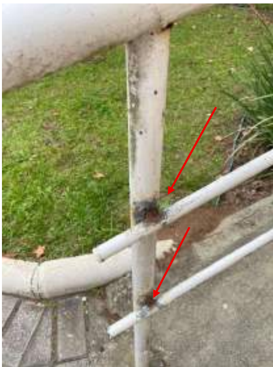
Fotografia 45 - Corrosão em corrimão metálico da rampa
