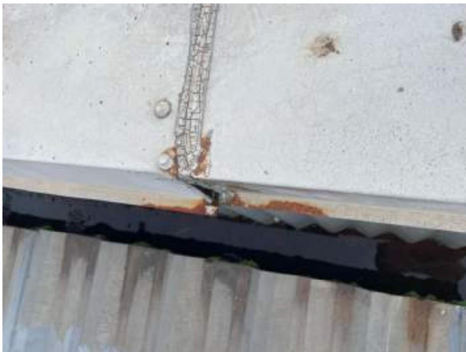
Fotografia 101 - Calhas com caimento irregular e presença de fungo e água parada / Deterioração das vedações dos rufos
