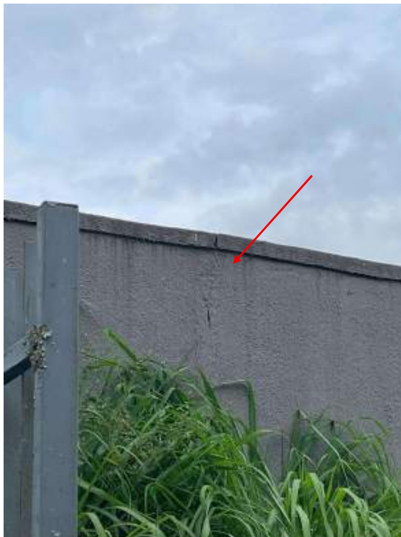
Fotografia 9 - Fissura por movimentação estrutural do muro
