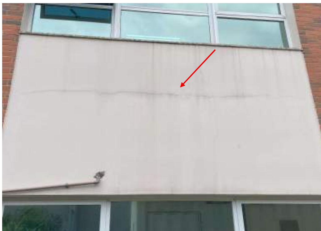
Fotografia 11 - Fissura por provável retração de argamassa / Infiltração
