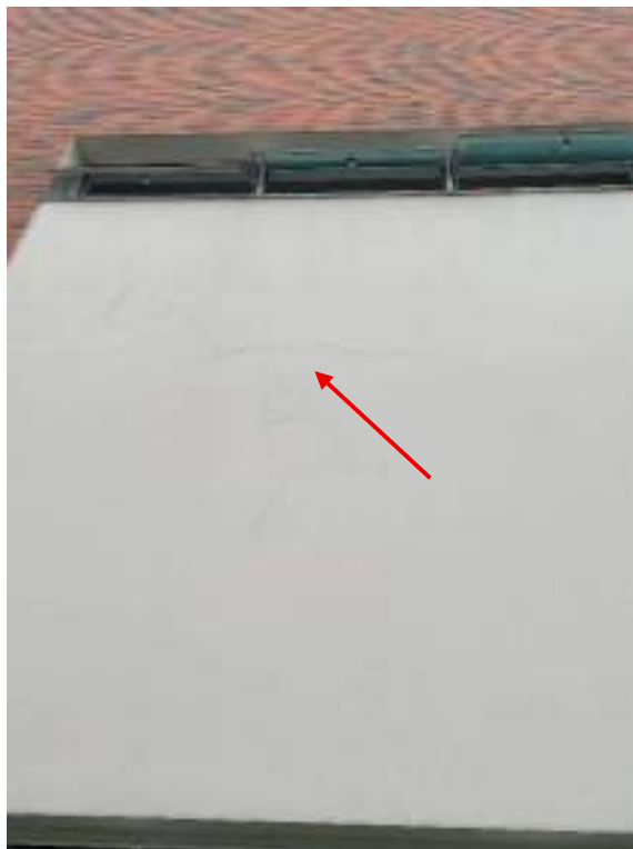
Fotografia 13 - Fissura por provável retração de argamassa / Infiltração
