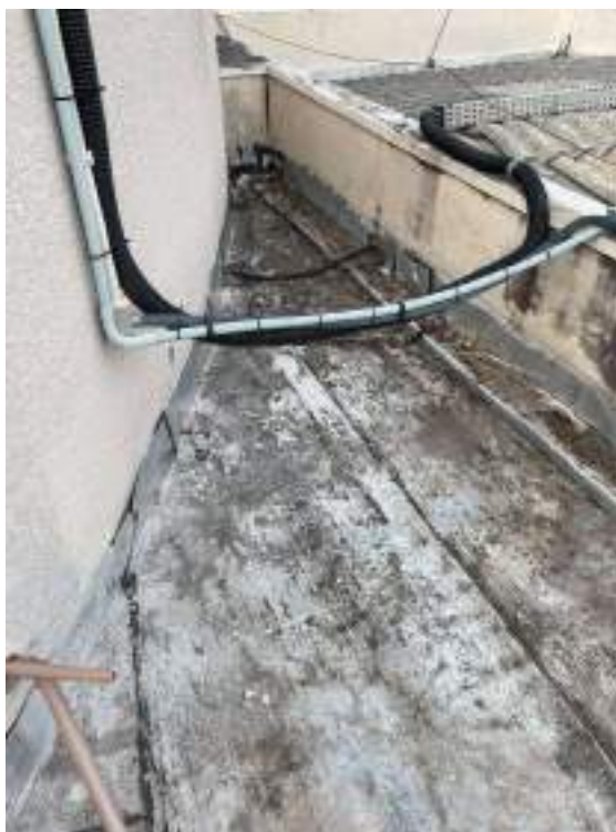
Fotografia 79 - Impermeabilização ineficiente; laje do auditório do plenário
