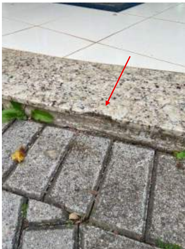
Fotografia 125 - Soleira de granito danificada
