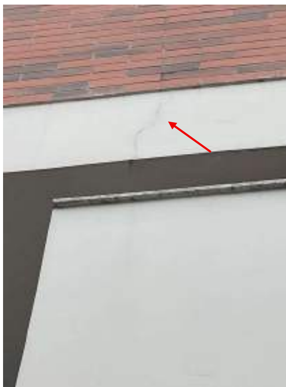
Fotografia 70 - Fissura por provável retração de argamassa
