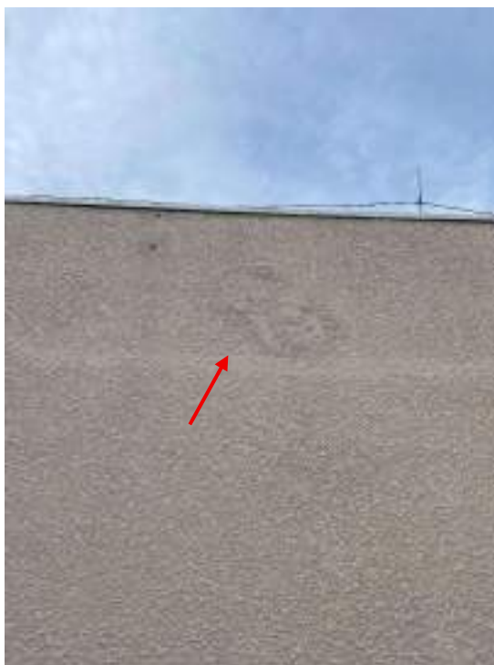
Fotografia 50 - Infiltração em revestimento tipo emboço de fachada
