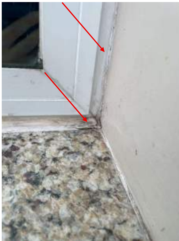
Fotografia 28 – Degradação das juntas de silicone
