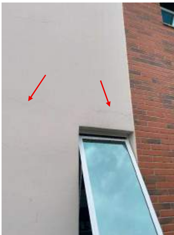
Fotografia 71 - Fissura por provável retração de argamassa
