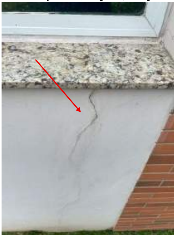
Fotografia 27 - Fissura por provável retração de argamassa.
