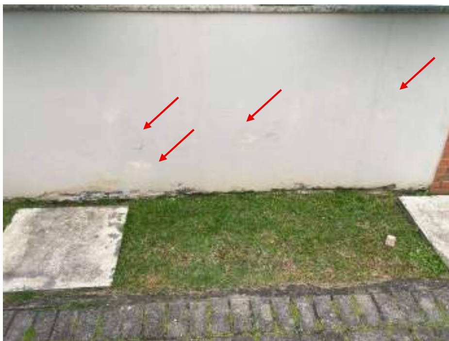
Fotografia 15 - Fissura por provável retração de argamassa / Infiltração Classificação: Vício, congênito / adquirido, endógeno.
