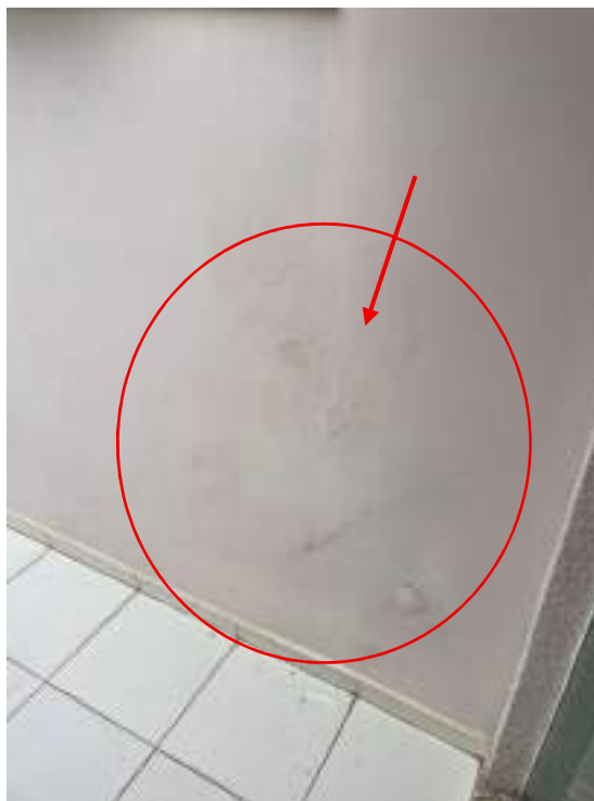
Fotografia 55 - Infiltração parede externa
