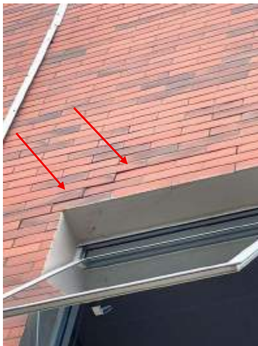
Fotografia 29 – Indícios de falha no rejuntamento e possível infiltração.
