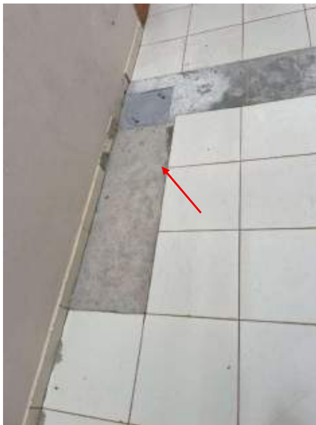
Fotografia 63 - Desplacamento de peças cerâmicas
