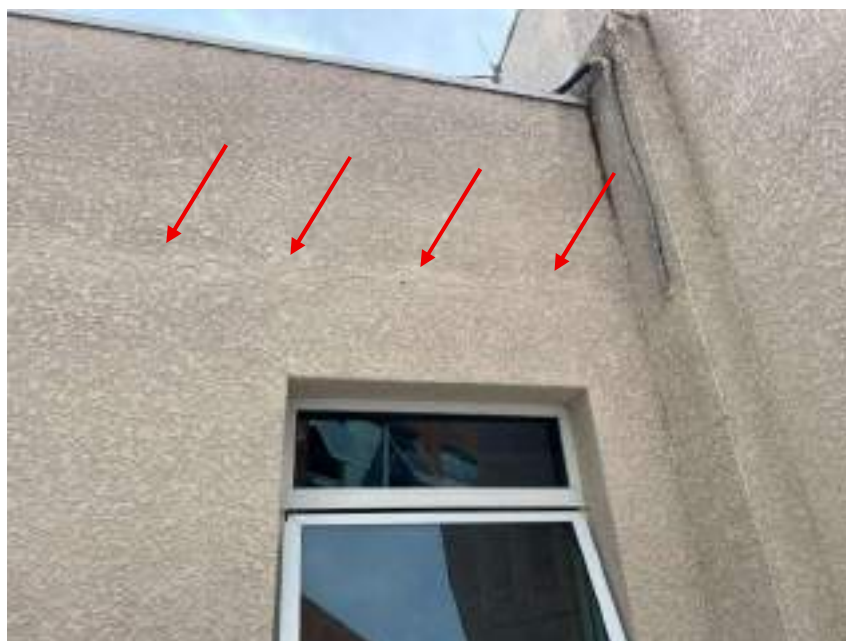
Fotografia 65 - Fissura por provável retração de argamassa / Infiltração
