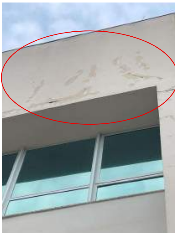
Fotografia 33 - Fissura por provável retração de argamassa
