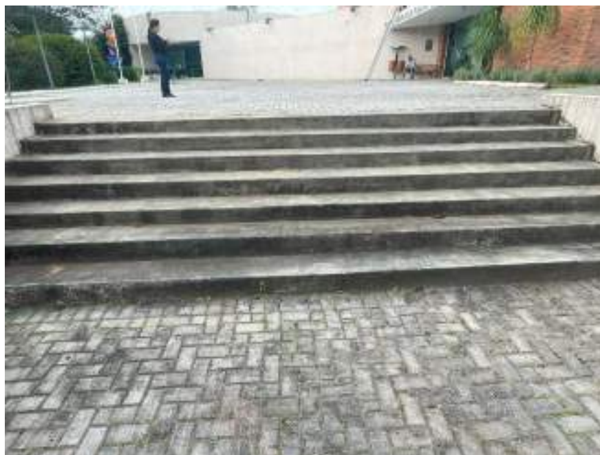
Fotografia 126 - Fissuração contrapiso escada de acesso
