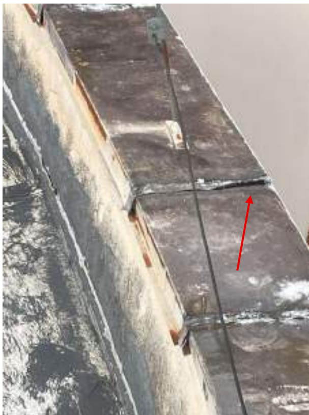
Fotografia 98 - Rufo deteriorado sem vedação entre chapas
