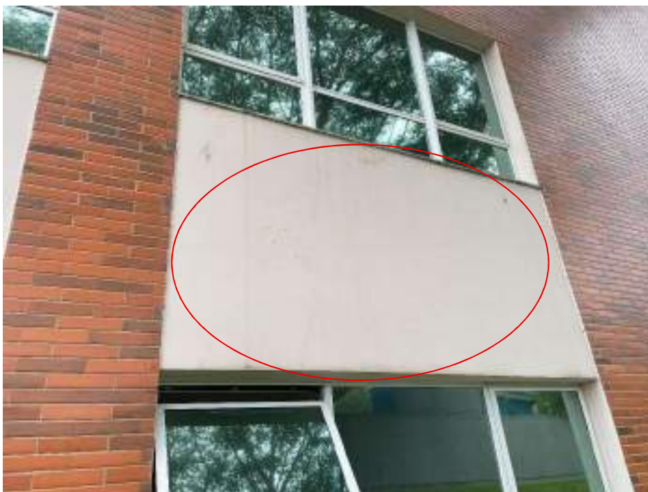
Fotografia 26 - Fissura por provável retração de argamassa.
