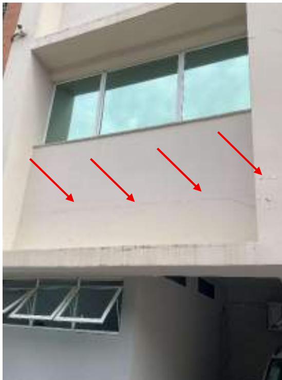
Fotografia 34 - Fissura por provável retração de argamassa
