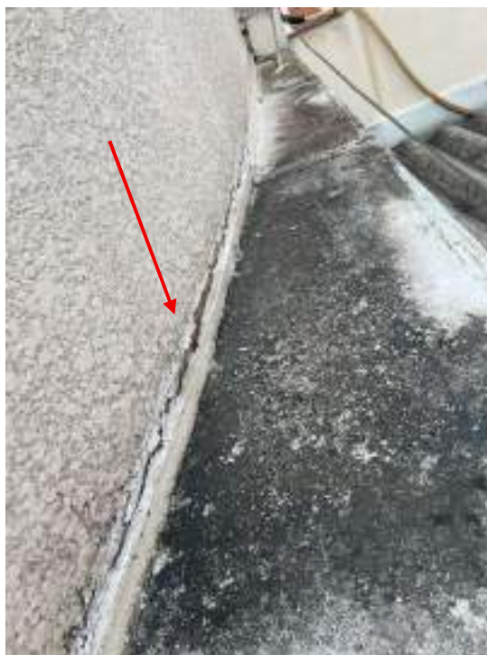
Fotografia 94 - Falta de vedação na interface rufo/parede
