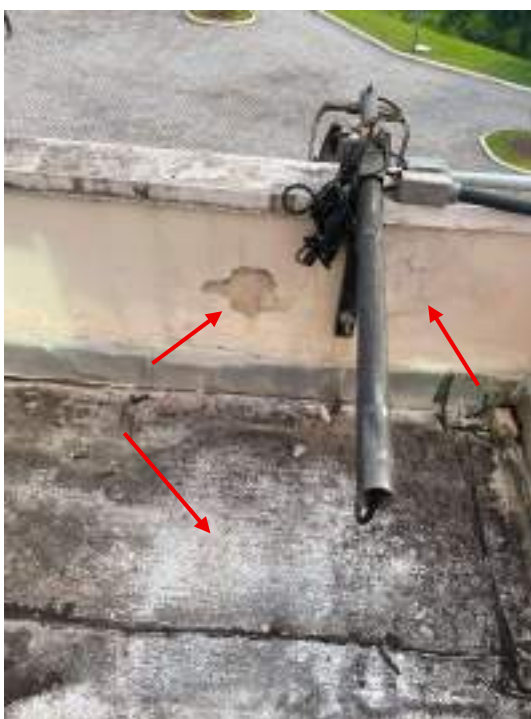
Fotografia 87 - Sistema de impermeabilização ineficiente / infiltrações na platibanda
