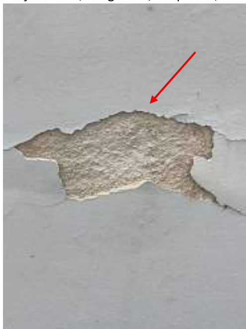
Fotografia 18 - Pulverulência de revestimento tipo emboço de fachada
